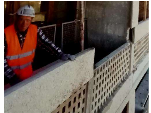
Fig.57. Chantier de restauration de la façade-est (2015-2017) : Préfabrication à pieds d'œuvre et remplacement des parements en béton armé des loggias reconstruits à l'identique
