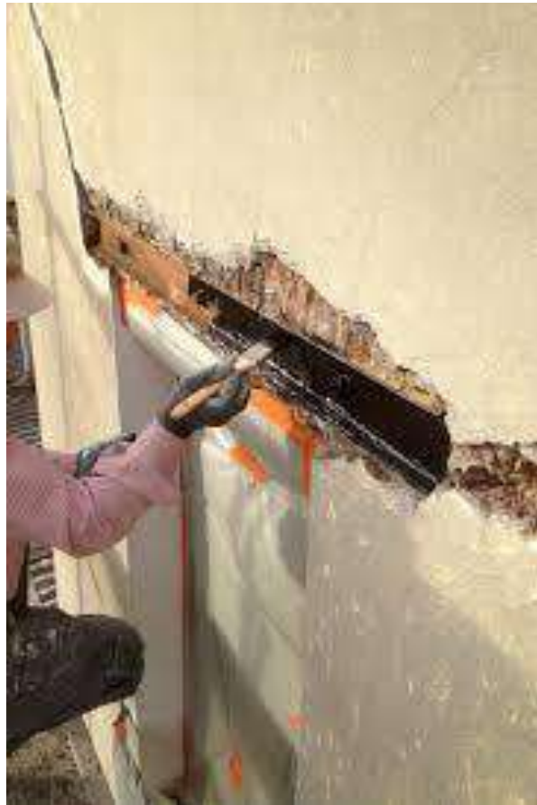
Fig.74. Travaux de piquage des enduits fissurés des façades
