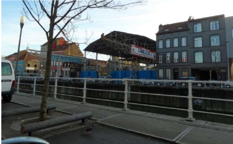
Fig.20. Vue sur la Halle Libelco, avant sa transformation. Source : https://www.metrolab.brussels/imagecache/large/1507896258-fig-12.JPG
