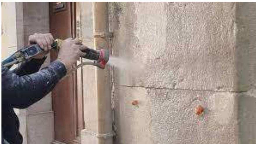
Fig.72. Travaux d'hydro-lavage sur une surface de façade
