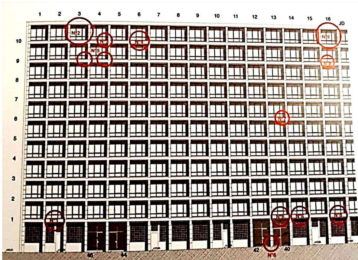
Fig.65. Reconnaissance du bâti, enveloppe verticale : Façade sud-ouest (source : Graf & Delemontey, 2020)
