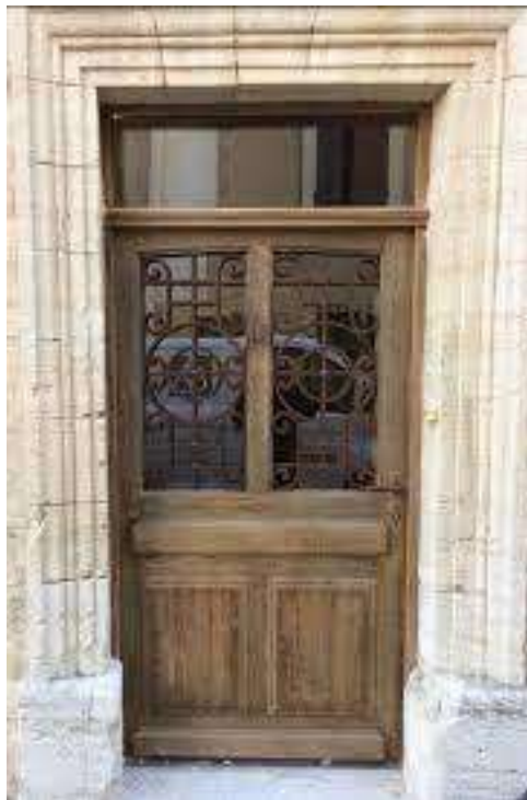
Fig.90. Vitrage de la porte d'entrée
