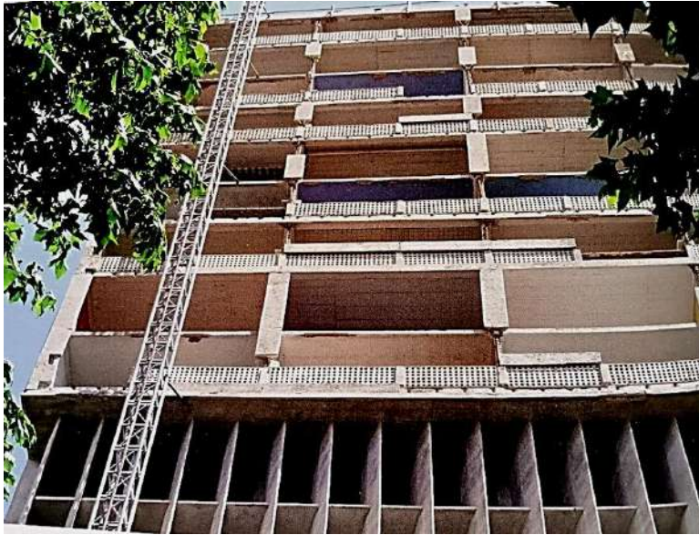
Fig.56. Chantier de restauration de la façade ouest (2001-2008) (source : Graf & Delemontey, 2020)
