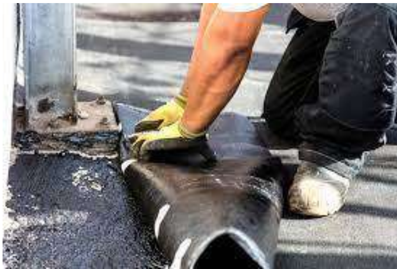
Fig.92. Exécution de l'étanchéité
