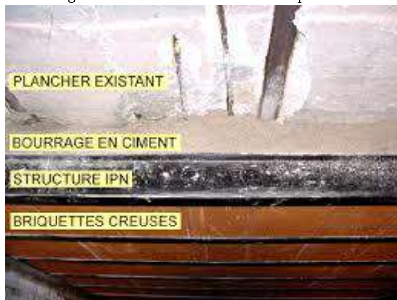
Fig.76. Travaux de consolidation d'un plancher à voutains
