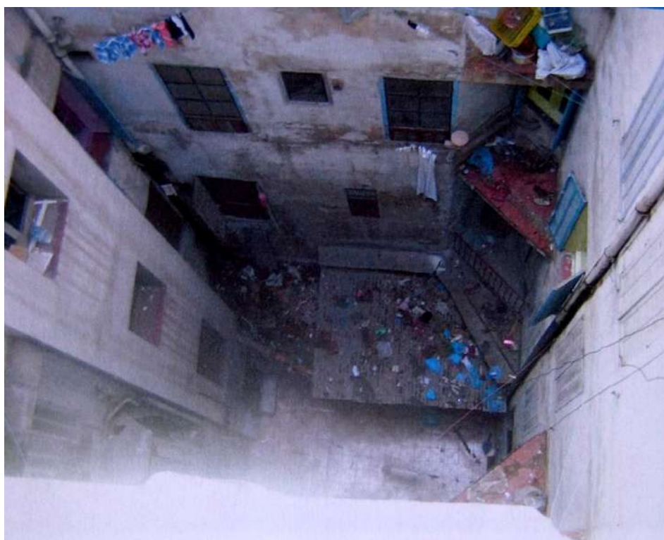
Fig.69. Vue sur l'intérieur d'une cour
