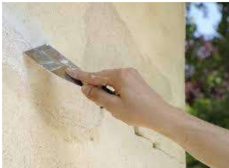
Fig.80. Remplissage des fissures
