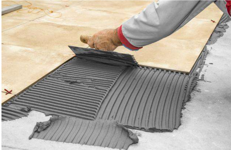
Fig.89. Pose du nouveau revêtement de sol de la cour
