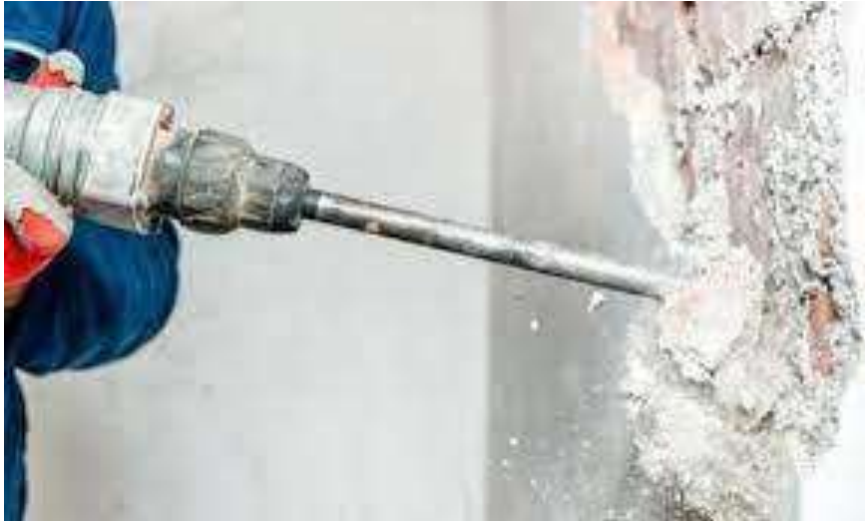
Fig.73. Travaux de piquage des enduits altérés des façades
