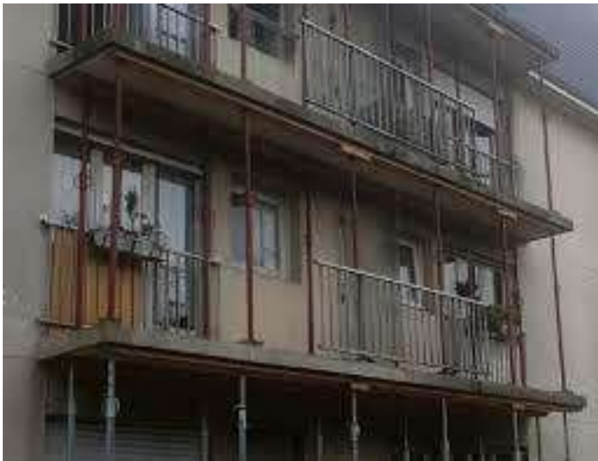
Fig.78. Travaux de consolidation d'un plancher de balcon
