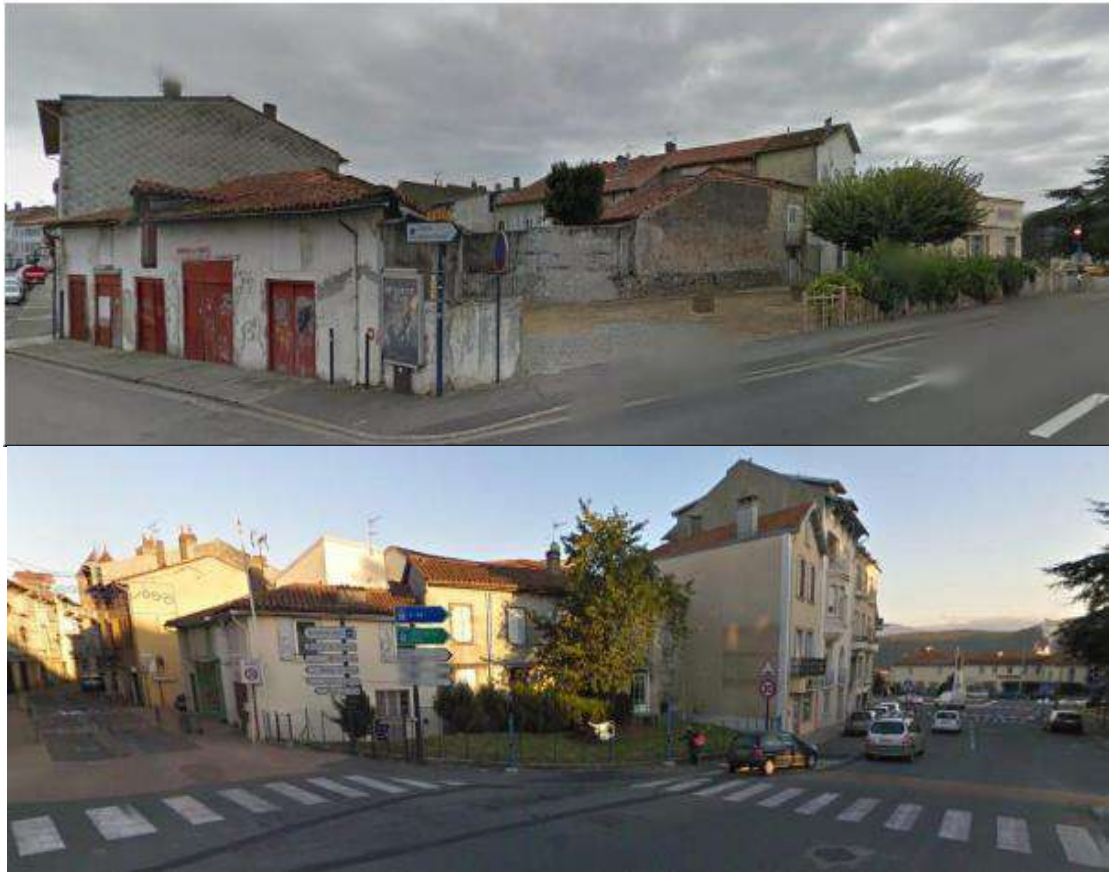
Fig.8. Ilots dégradés dans le centre historique de Saint-Gaudens. Source : https://www.stgo.fr/wp-content/uploads/2017/05/4.3_Note-de-pr%C3%A9sentation-finalis%C3%A9e_Mai-2015.pdf
