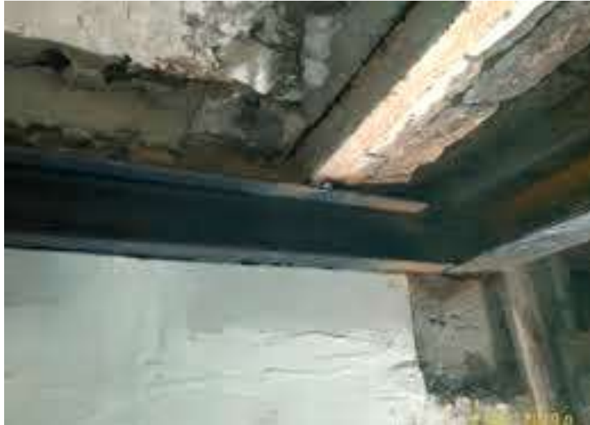
Fig.77. Travaux de consolidation d'un plancher
