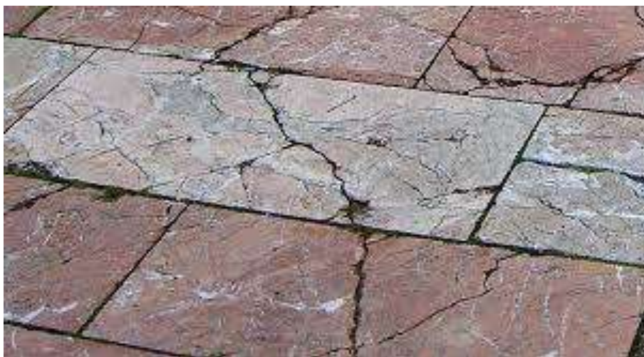
Fig.87. Dégradation du revêtement de sol de la cour
