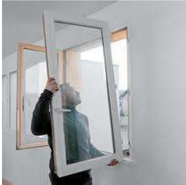
Fig.86. Remplacement des fenêtres
