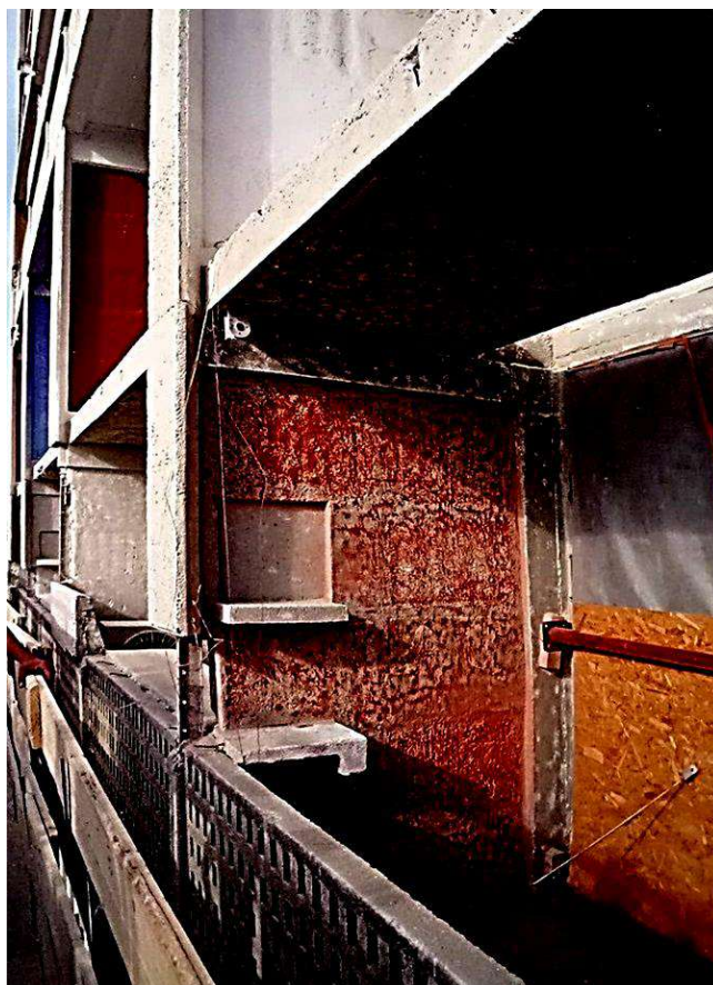
Fig.62. Chantier de restauration de la façade ouest (2001-2008). Détail d'une loggia, 2007.
