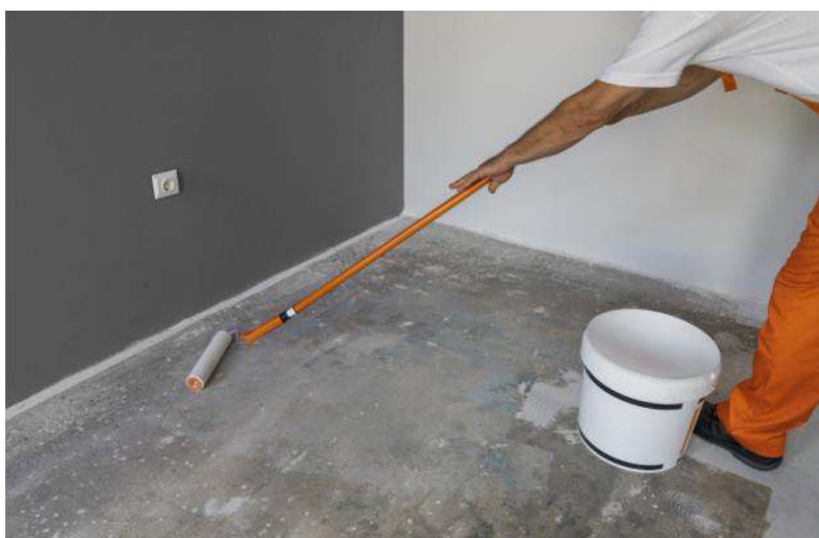
Fig.88. L'application de la couche d'imperméabilisation
