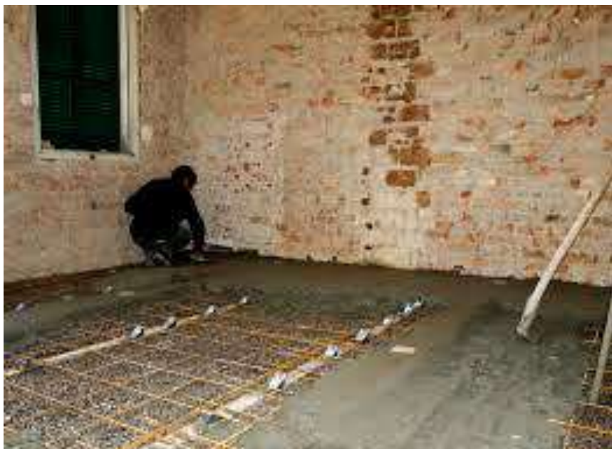
Fig.75. Travaux de consolidation d'un plancher
