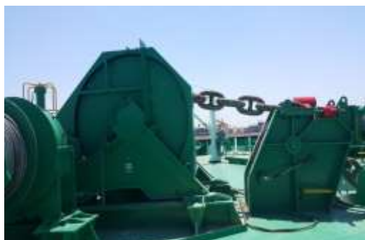
Figure III.15: Chaîne entre le guindeau (à gauche) et les stoppeurs (à droite)
