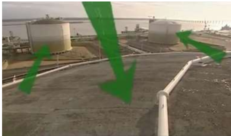
Figure I.3 : Réservoirs du stockage
