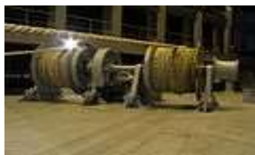
Figure III.18: Guindeau avec enrouleurs d'aussières et poupées sur un porte-conteneurs
