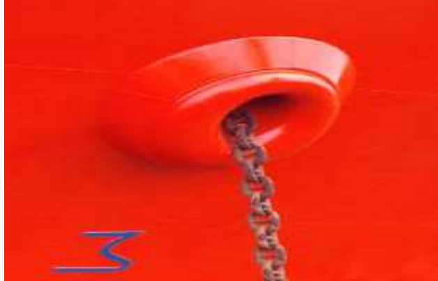
Figure III.20 : Renforcement de coque en sortie d'écubier.
