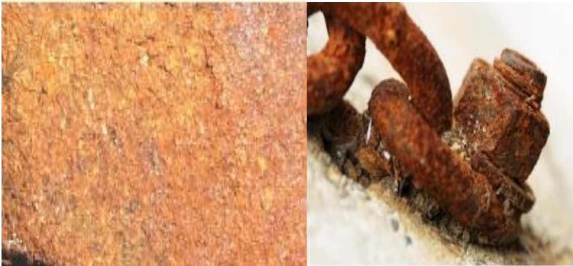
Figure 8 : Exemples de corrosion uniforme.
