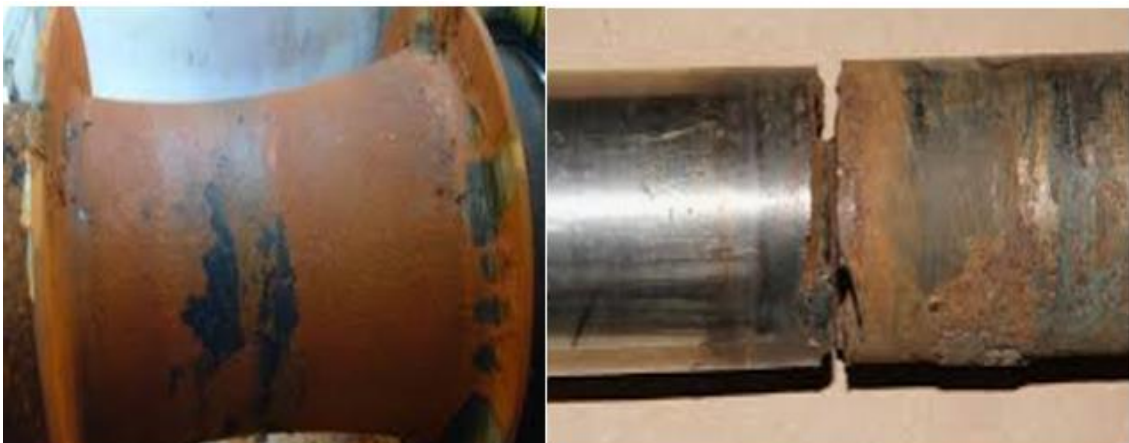
Figure 17 : Photos de la fatigue-corrosion.
