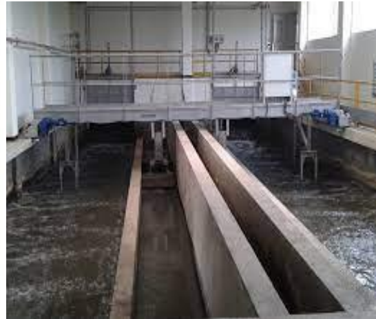
Fig.III.4. Pont dégraisseur/dessabler racleur longitudinale (google)
