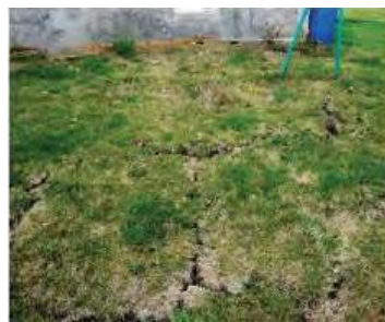
Figure 60. Les déblais argileux des terrassements ont été régalés sur le terrain.
