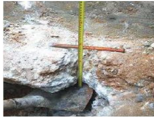
Figure 62. Sondage manuel sur une semelle de fondation.
