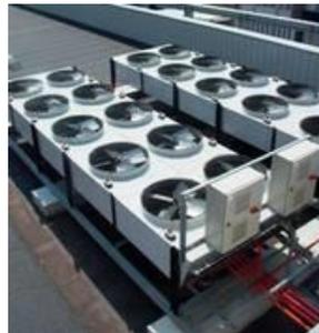
Figure 23 – Vue de condenseur à air [07]
