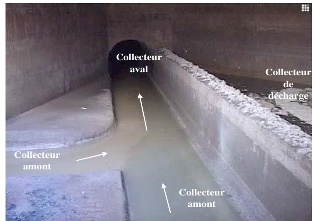
Figure 5. 8. Schéma de principe du déversoir frontal (Engees / Veolia Water Anjou Recherche)
