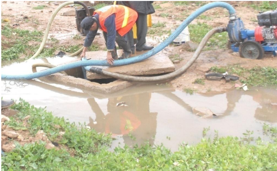
Figure 6. 2. Vidange des regards (Photographie de terrain)
