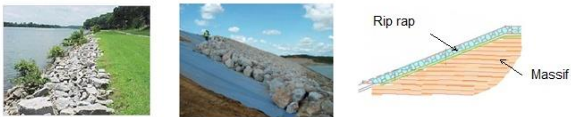
Figure 39: Protection amont en enrochements
