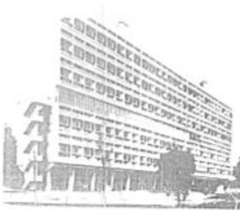
Unité d'habitation de grande hauteur conforme architecte: Le Corbusier 1945-1952. Source: F. Guichot - Il était une fois l'habitat - Ed. Mouton
