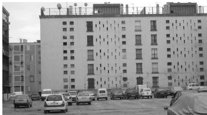
Photo. 2-1 : Vue sur la ZHUN Hai El Zitoun à Maraval Source : Auteur
