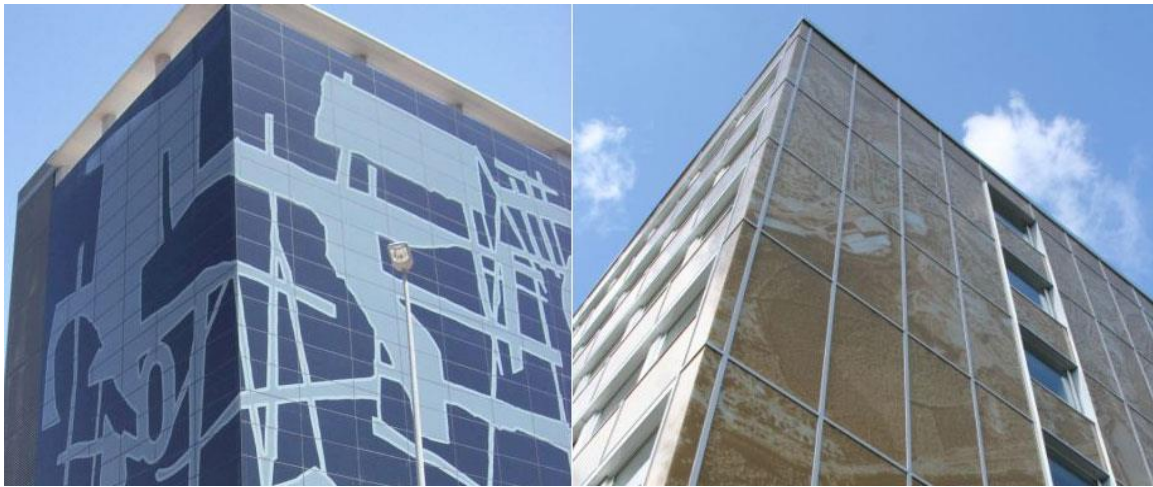
Figure II.24 : vitrage sérigraphié ; motif sur façade [35].
