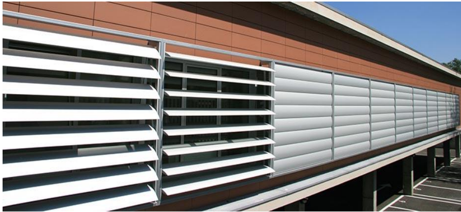
Figure II.26 : Brise-soleil ou pare-soleil en aluminium (métal) [37].
