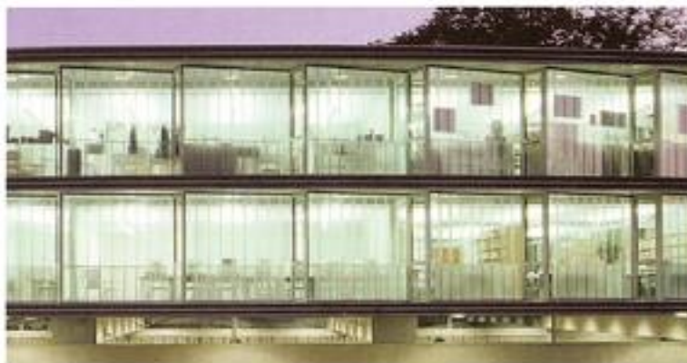
Figure II.7 : Verre profilé en U pour façade [13].
