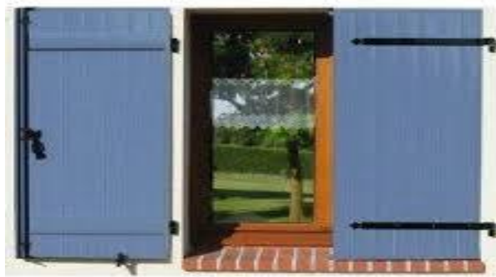
Figure II.31 : Volet battante à l'extérieur de la fenêtre [42].
