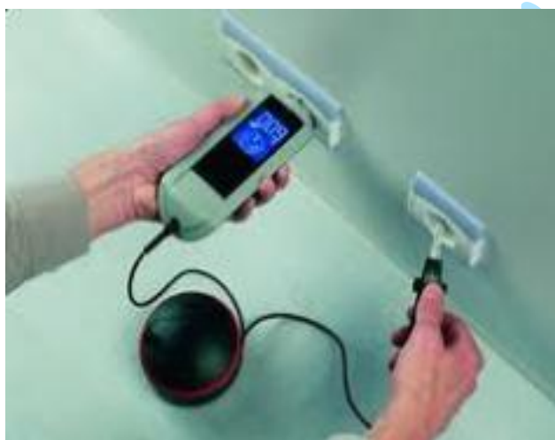
Exemple de mesure de continuité du PE entre 2 prises.
