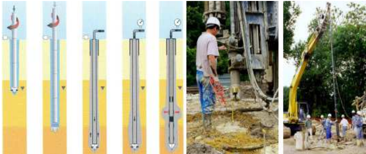
Figure 2-11 : Réalisation d'un micropieux pour les écrans antibruit de l'autoroute A4 (photographies S. Borel) [21]
