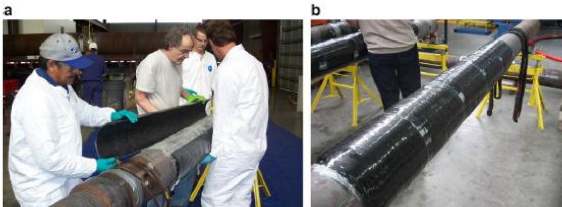
Figure II.10 : (a) Installation de la moitié de la coquille du composite en carbone, (b) réparation finale en composite
