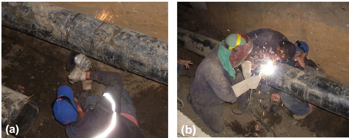
Figure II.9 : Changeement du tronçon endommagé d'une canalisation, (a) découpage, (b) ré-soudage
