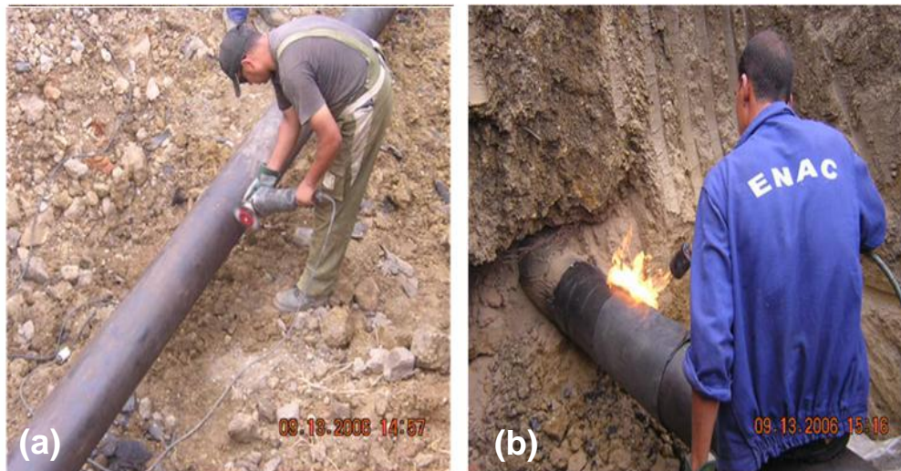
Figure II.8 : (a) réparation de surface pour réfection enrobage, fuite de bentalha (Oran, Algérie), (b) réfection enrobage
