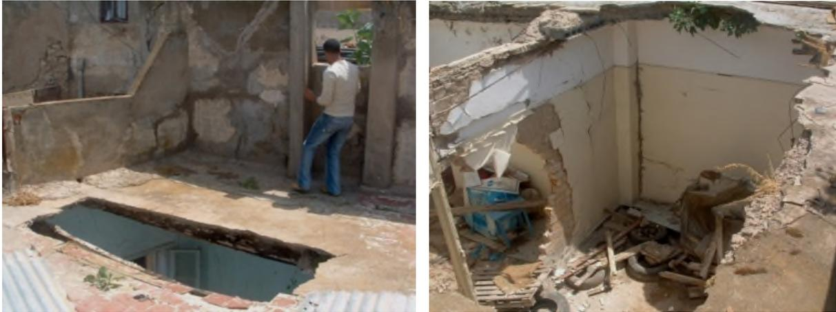
Photos 59 et 60 : Vues sur la dégradation avancée d'éléments porteurs de constructions localisées au n°11 rue de ravin blanc, au quartier Gambetta. Source : DUC, 2011
