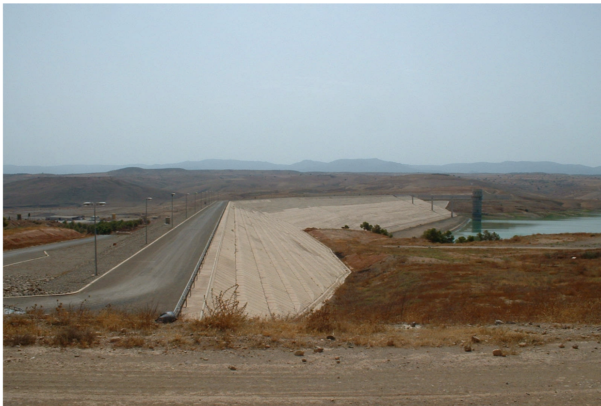
Figure VI.14 : Illustration de Barrage Hammam Boughrara
