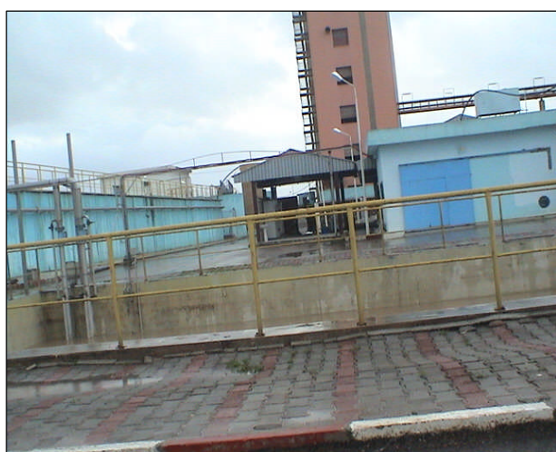
Figure VI.6: MAISERIE a) Vue intérieure
