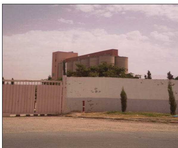
b) Vue extérieure
