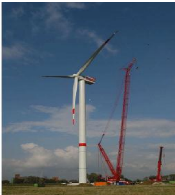
Figure 1.4 - l'éolien de 5MW (REpower)
