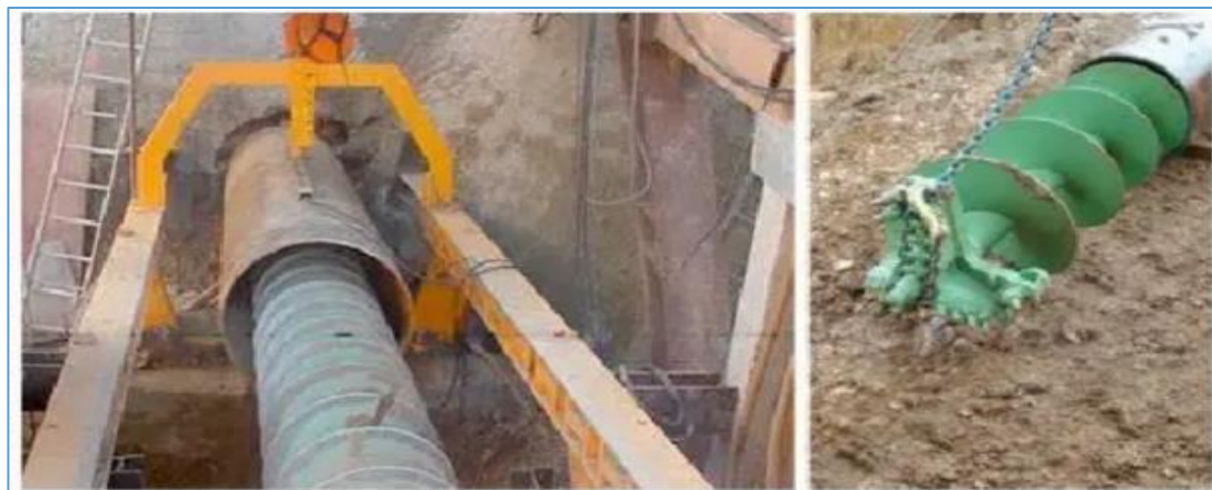
Figure 2.6 Foreuse horizontale (Tête de forage)
