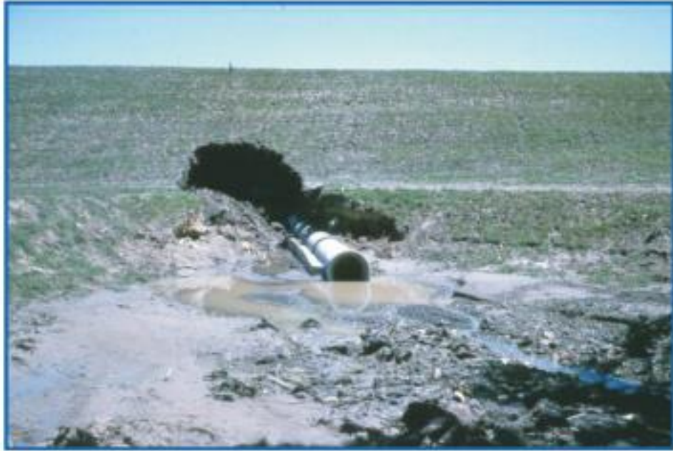
Figure 10: Désordre causé dans un barrage en terre suite au développement d'un renard le long d'une conduite.
