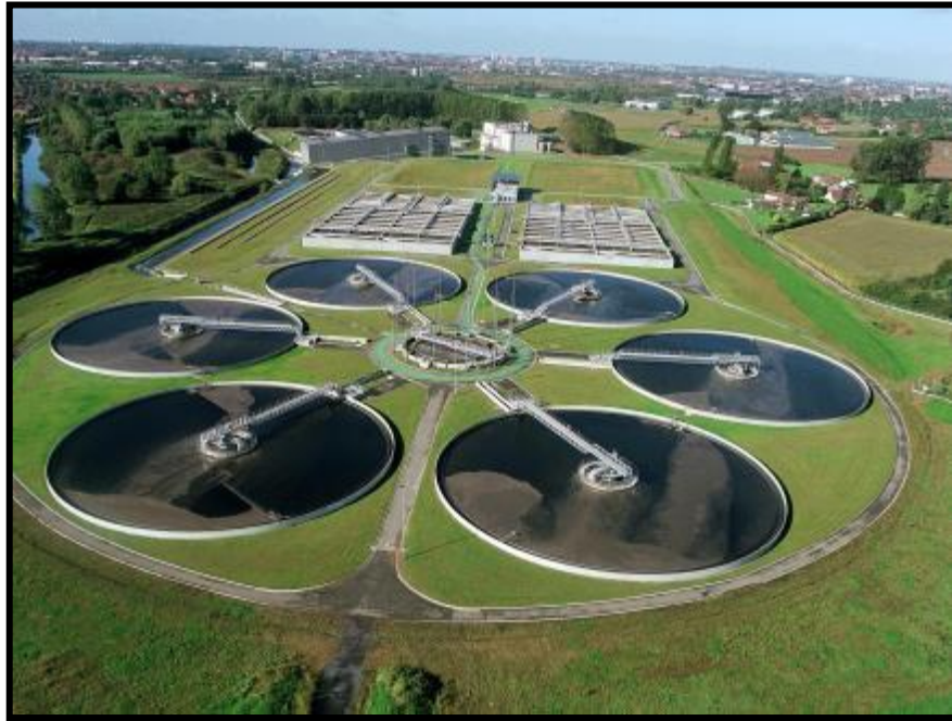
Figure3- photo d'une station d'épuration
