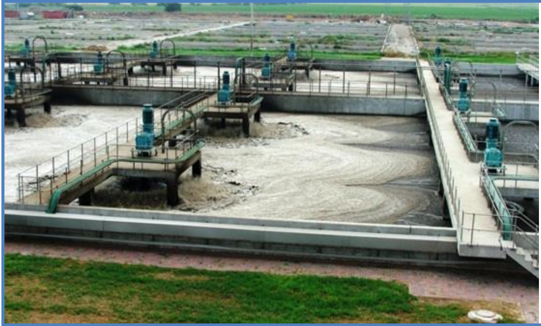
Figure 6-Bassin d'aération
