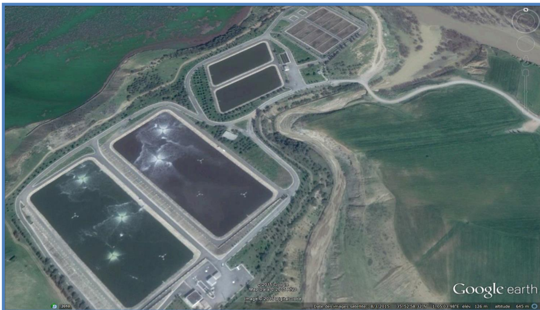
Figure10- photo de Lagunage Aéré
