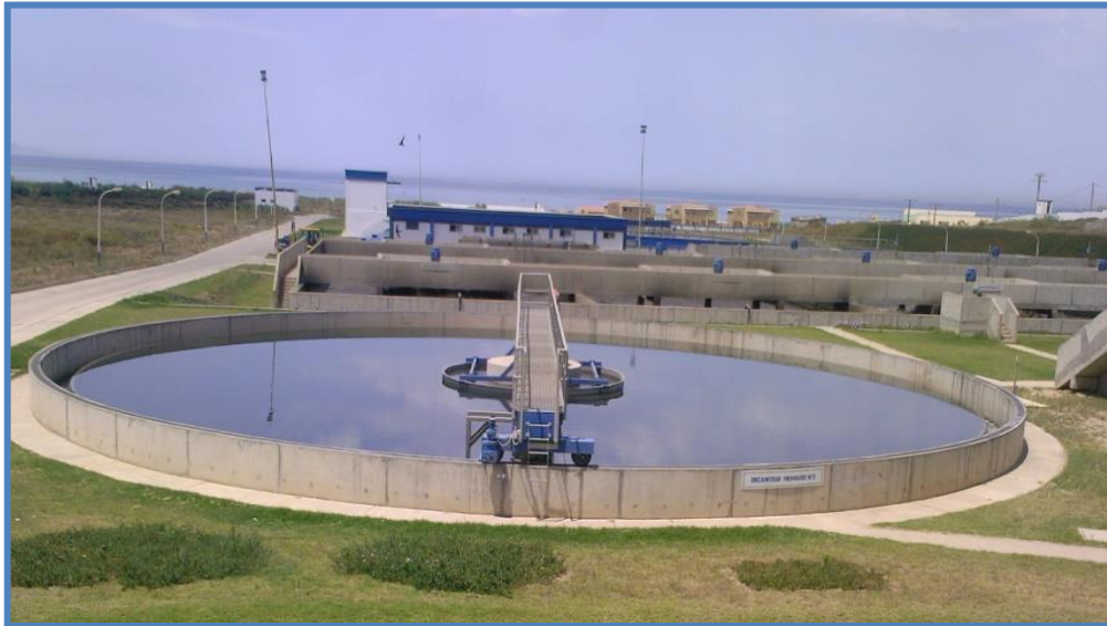
Figure5-photo de décanteur Primaire
