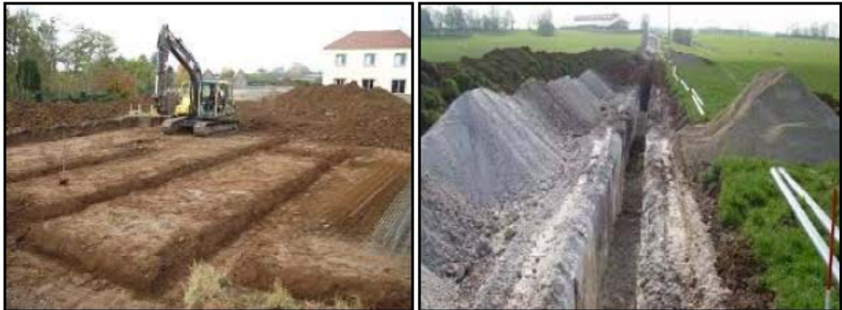
Figure 11. Excavations en tranchée et en rigole.
