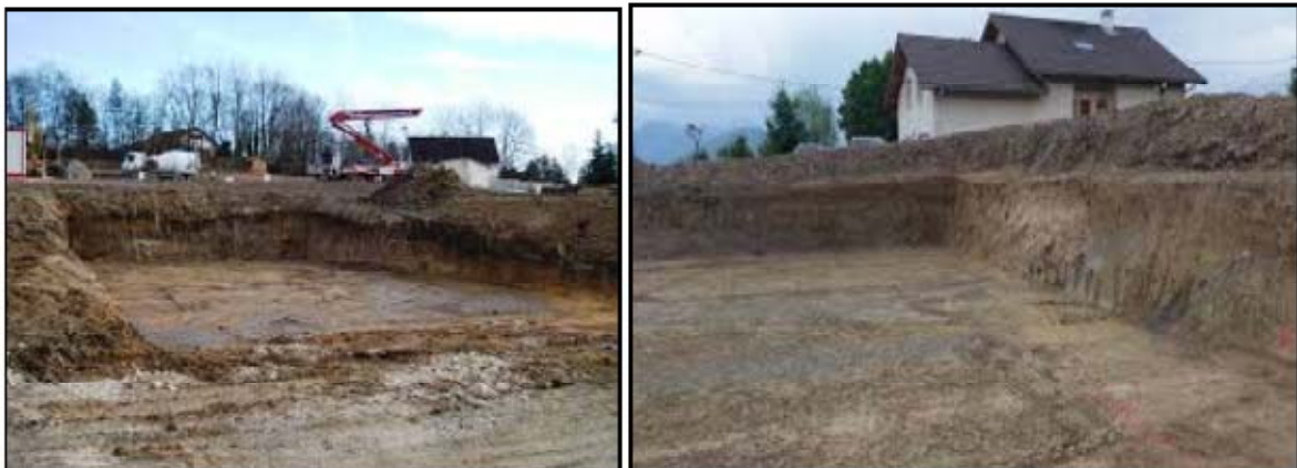
Figure 9. Excavations en pleine masse.
