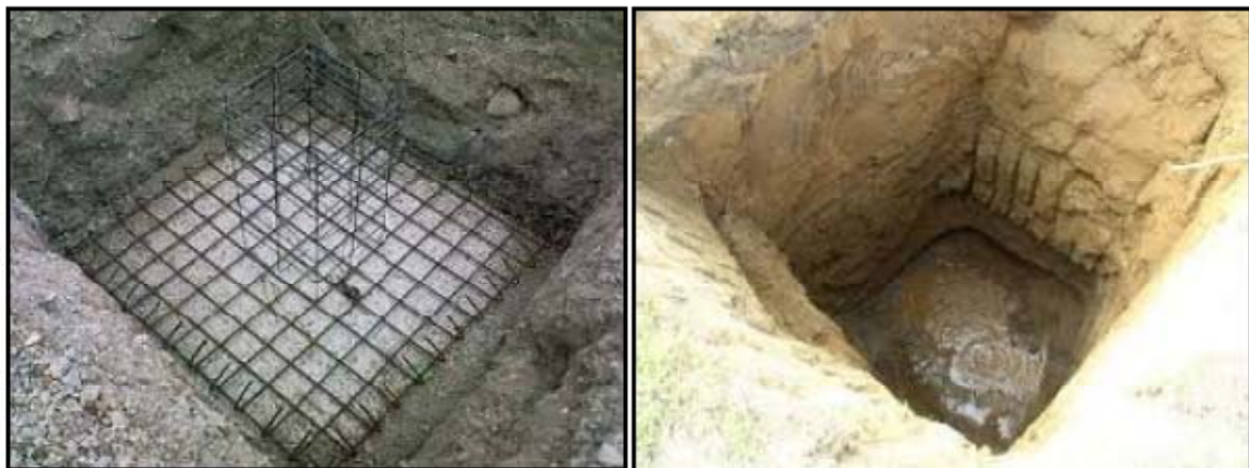
Figure 12. Excavations en puits.
