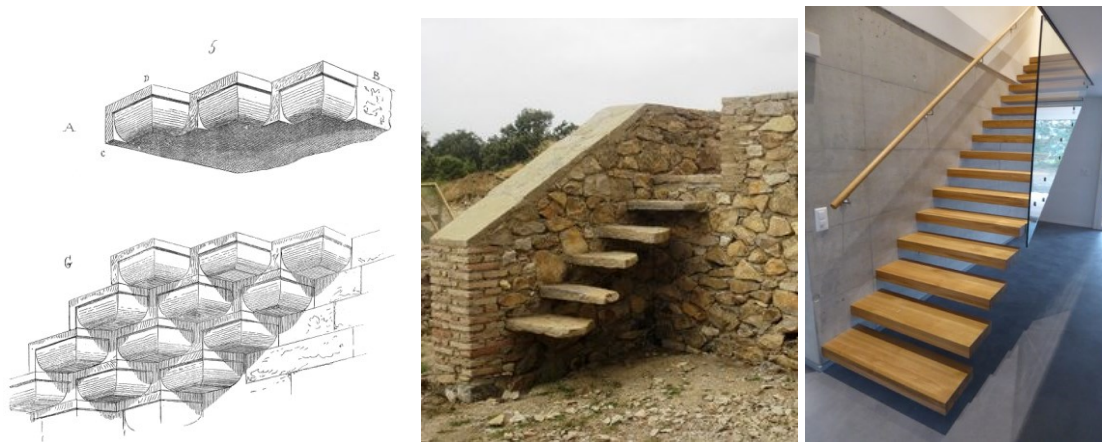
Figure 110 : Des escaliers en encorbellement en pierre et en bois. Réf. Internet.
