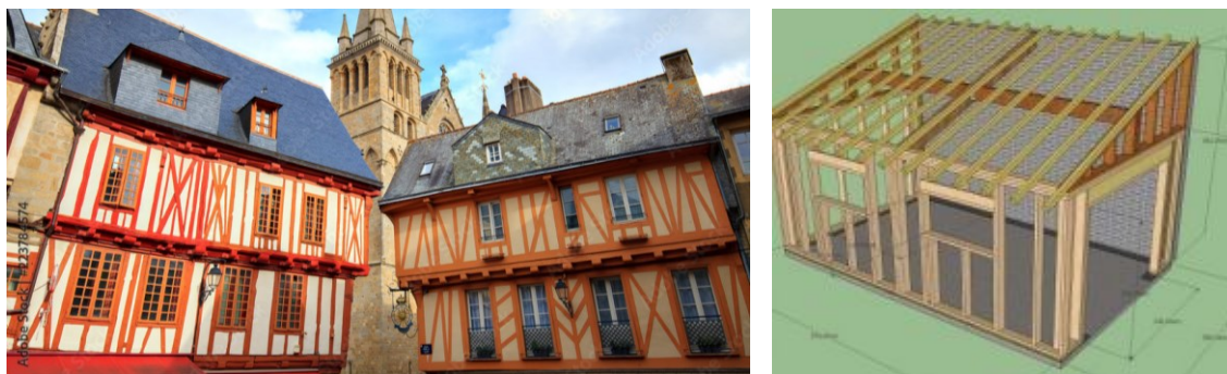
Figure 97 : structures portantes en bois traditionnelles et modernes, à colombage et en pans de bois. Réf. : Internet.
