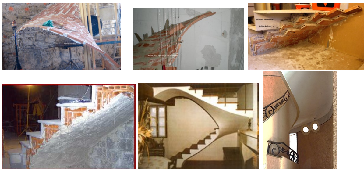
Figure 109 : Etapes de réalisation d'un escalier sur voûte sarrasine. Réf. : Internet et L. Kara Mostefa.
