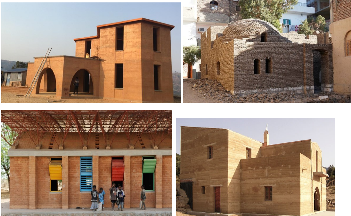
Figure 96 : Edifices construits avec des murs porteurs en terre avec la bauge, l'adobe, la BTC et le pisé. Architectes Hassan Fethi, Francis Kéré, Paul Casalonga et François-Xavier Bartoli. Réf. : Internet.
