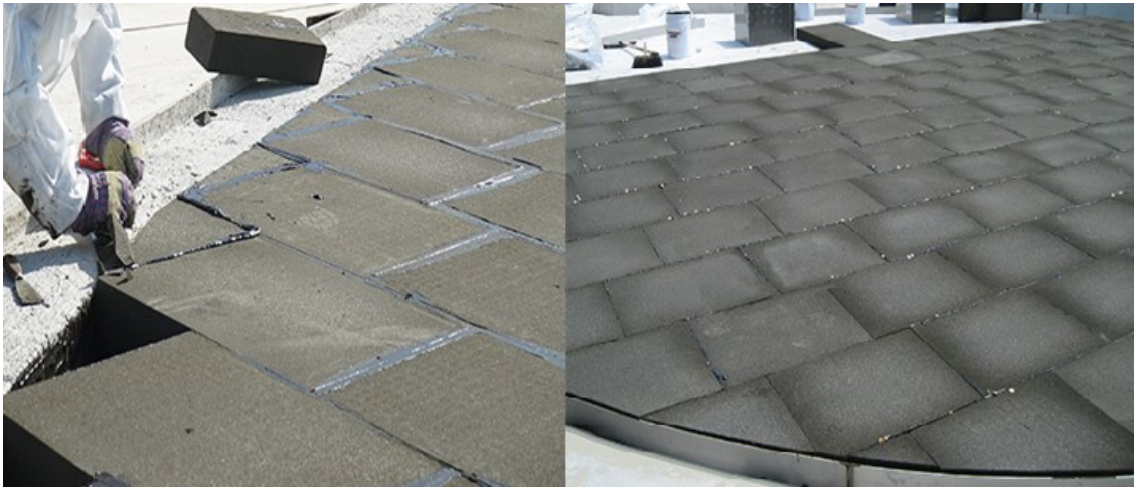
Figure II.3 : Système d'isolation pour base de réservoir
