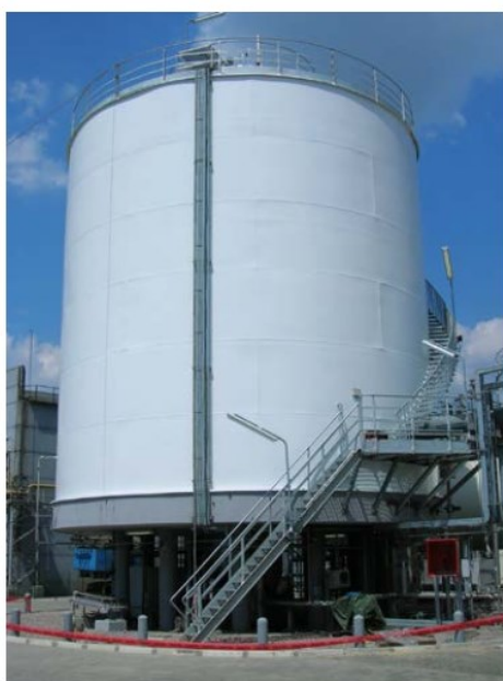
Figure I.1 : Bacs de stockage cylindriques verticaux
