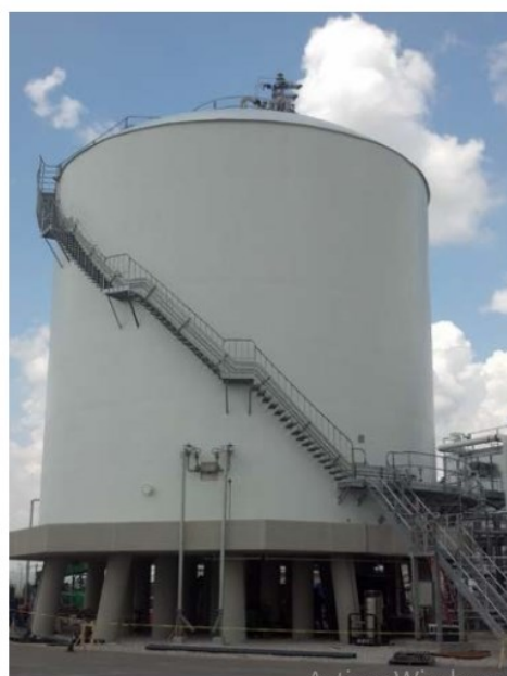
Figure I.1 : Bacs de stockage cylindriques verticaux
