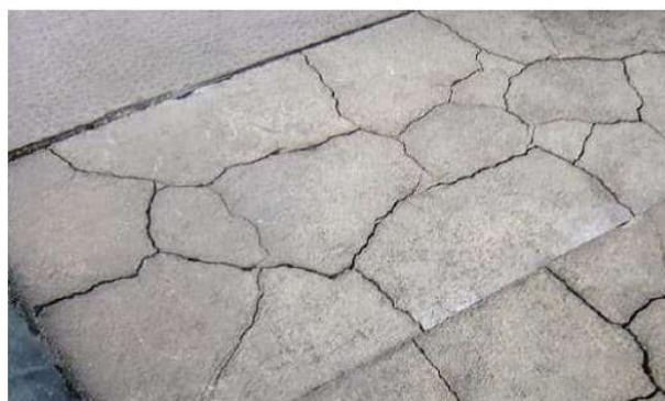
Dalle en béton fissurée suite à une formation retardée d'ettringite [11]
