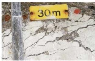
Fissures dans la masse du béton et décollement entre la pâte de ciment et le granulat.
