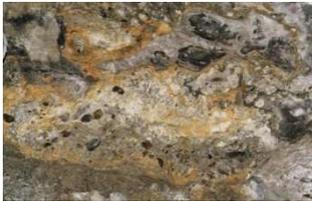
fissuration réseau provoquant des éclatements du béton et décollements de la surface.
