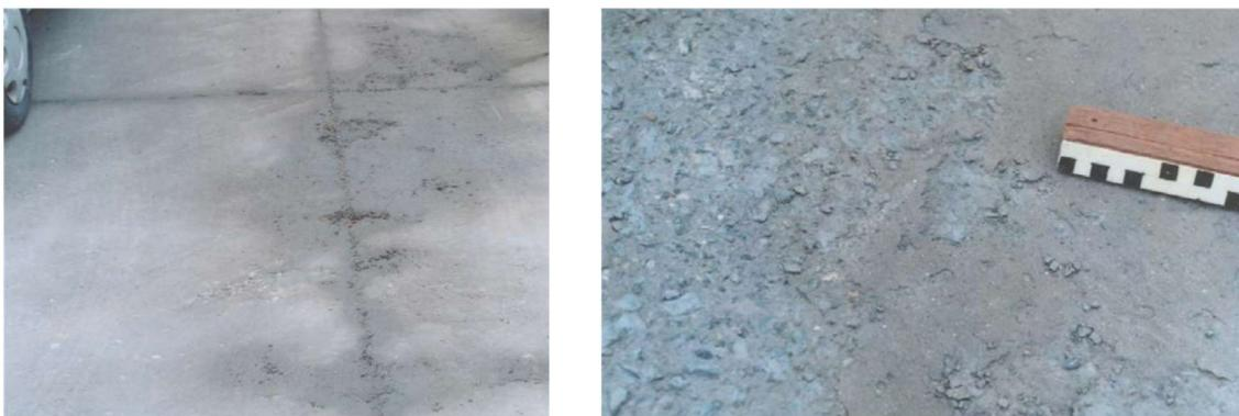
Figure 29 : Dégâts dus aux cycles gel/dégel en présence de sels de déverglaçage observés à la surface de revêtements de sols industriels [18]
