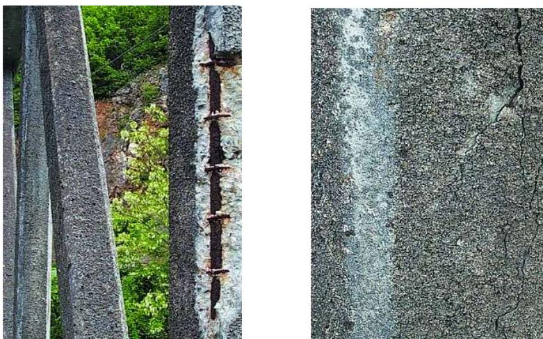
Figure 21 : Epaufrure laissant apparaître les armatures corrodées - Fissuration consécutive à la corrosion
