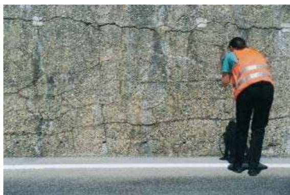
Figure 6 : Dégâts dus aux RAG dans un mur de soutènement non armé [9]
