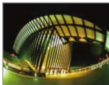
Structure de toiture
